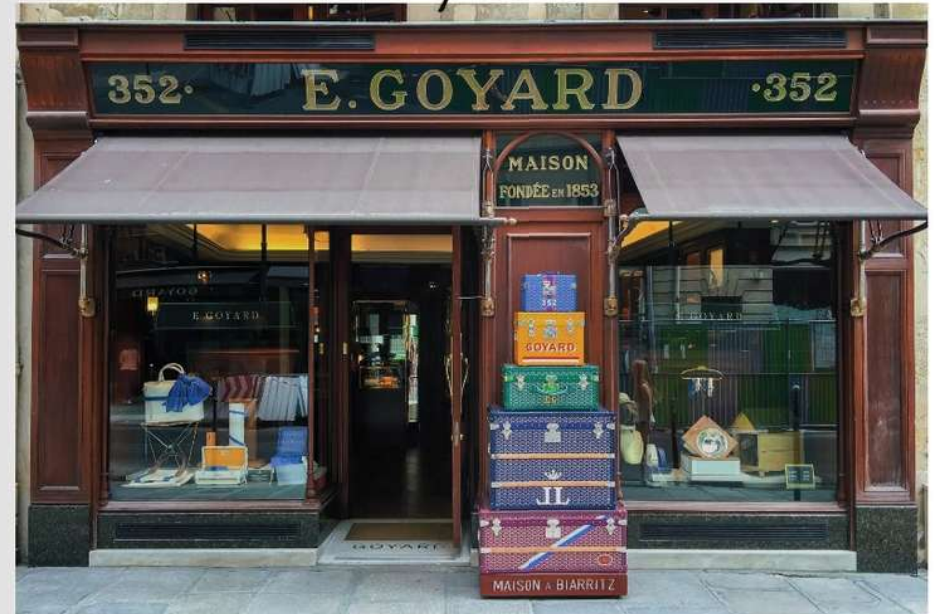
Réalisation finie de la façade de magasin
