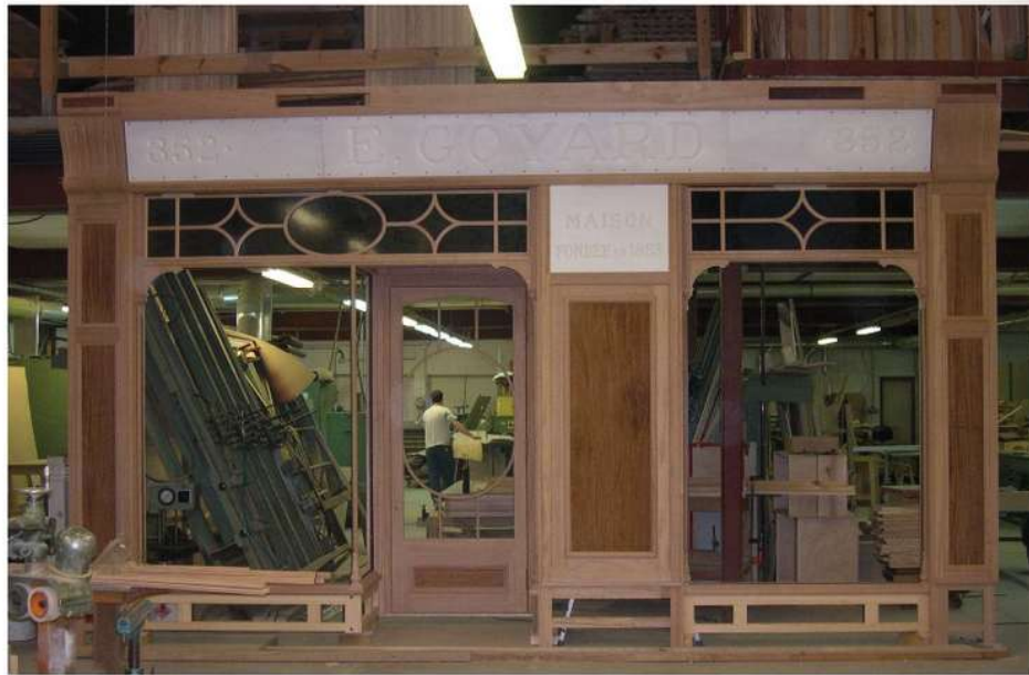
Façade de magasin en cours de fabrication à l'atelier
